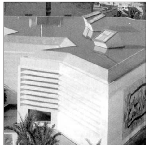
La cubierta de la Fundación Miró incorpora lámina sintética de PVC-P
